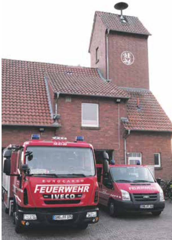
Das Feuerwehrhaus am Südring in Röcke beherbergt ein Tragkraftspritzenfahrzeug mit Wasser (TSF-W) und ein Mannschaftstransportfahrzeug (MTF).
